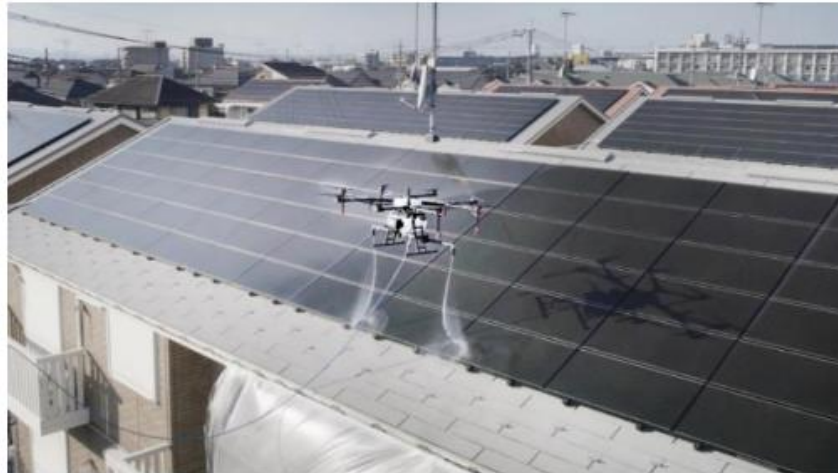
屋根部の洗浄の様子
